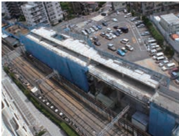
墨田区内の押上線連続立体化工事
